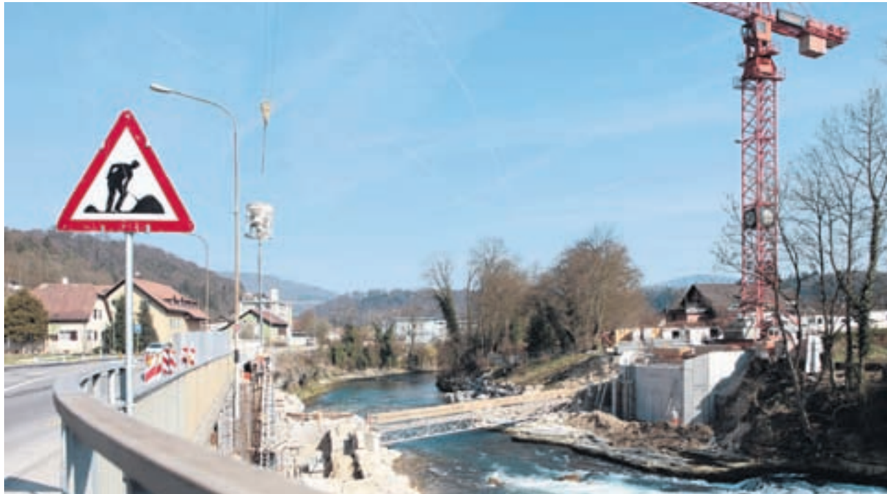
Streitfall. Zwischen alter und neuer Birsbrücke in Zwingen will die EBL ein neues Kleinwasserkraftwerk bauen. Foto Mischa Christen
