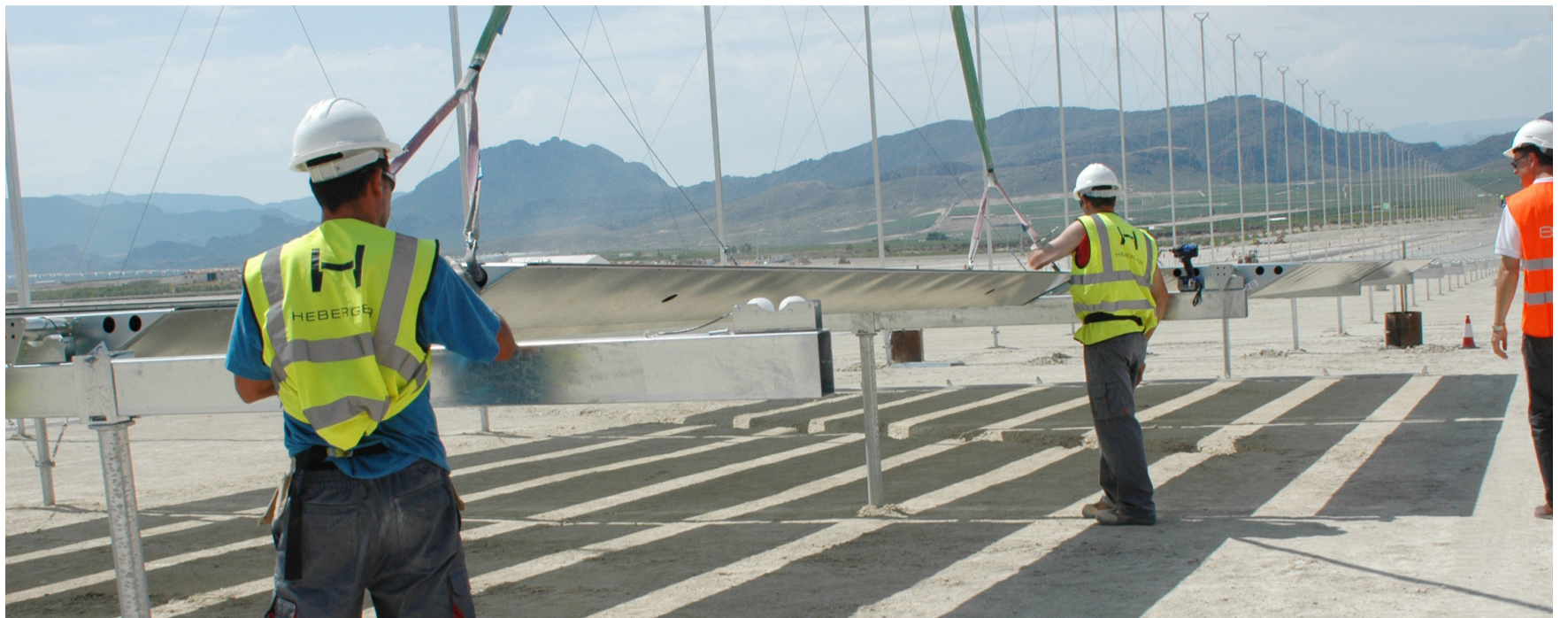
«Der Baufortschritt ist zügig und die Zusammenarbeit vor Ort funktioniert.», berichtet Leo Voser, Technischer Projektmanager des Solarkraftwerks. Bild: Josef Riegger
