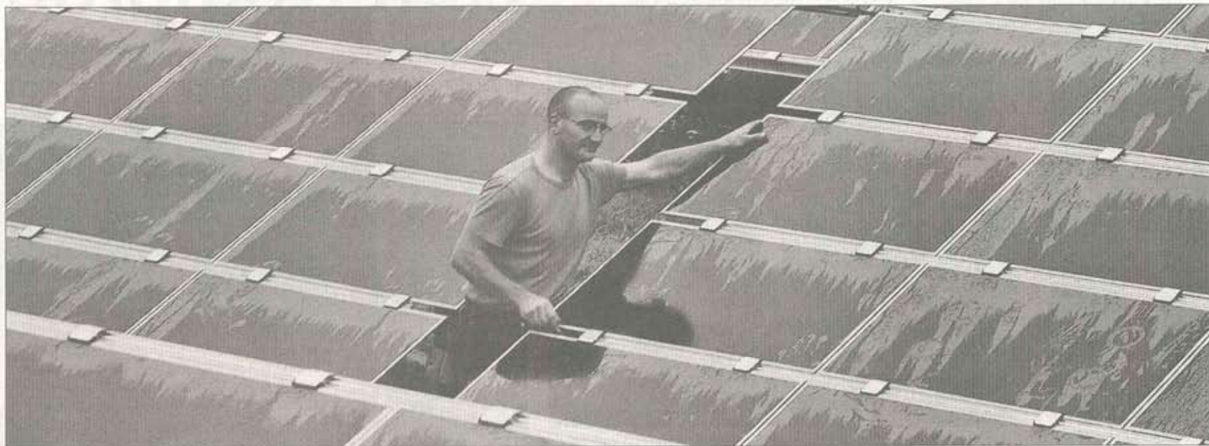
SONNENKOLLEKTOREN Ein Techniker kontrolliert Solarmodule bei einem Solarkraftwerk in Deutschland. KEYSTONE
