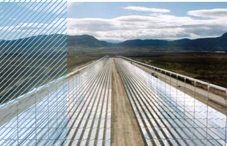
Das solarthermische Kraftwerk der Schweizer Investoren – ABB hält eine Beteiligung am Technologielieferanten Novatec Solar.
